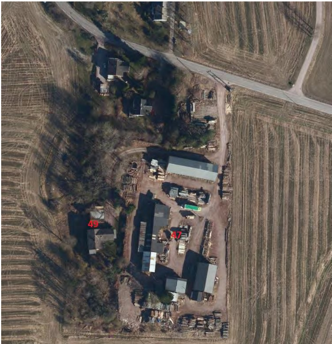
FIGUR 1 FLYFOTO OVER SOLERØDVEIEN 47. EIENDOMMEN HAR FELLES ADKOMST MED NR 49.
